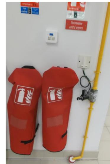
Illustration 1 : sécurité friteuse (couteux en investissement et fonctionnement) normalement hors sujet car les cuisines sont demandées fermées et non pas ouvertes
