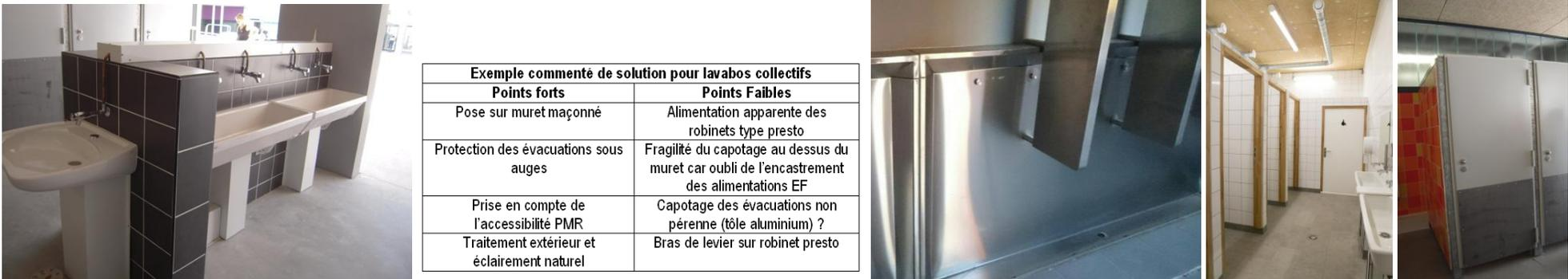
Schémas de principe et photos pour protection évacuation sous lavabos et urinoirs (collèges de CESTAS [grille inox], de ST SYMPHORIEN [stalles toutes hauteurs], LANGON (urinoirs inox stalles toute hauteur) et ALIENOR BdX [urinoirs inox suspendus et protection tôle des évacuations])
