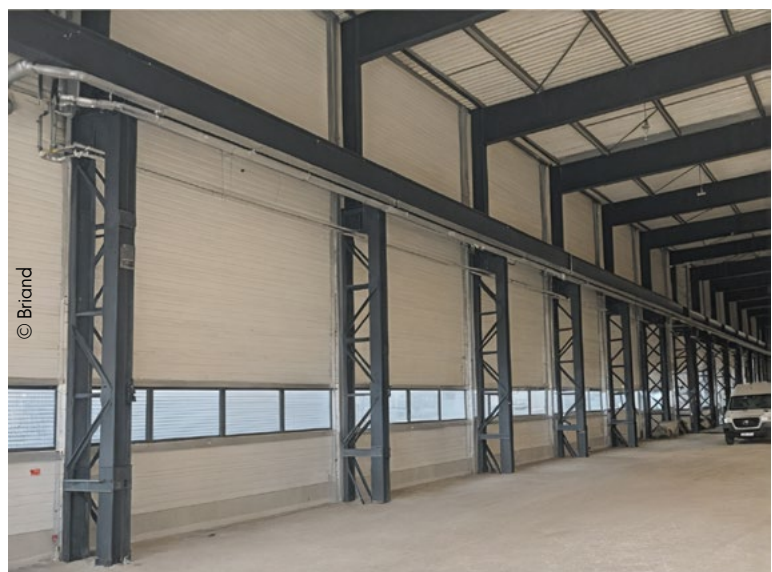
Nouveau bâtiment Briand aux Herbiers (85)
