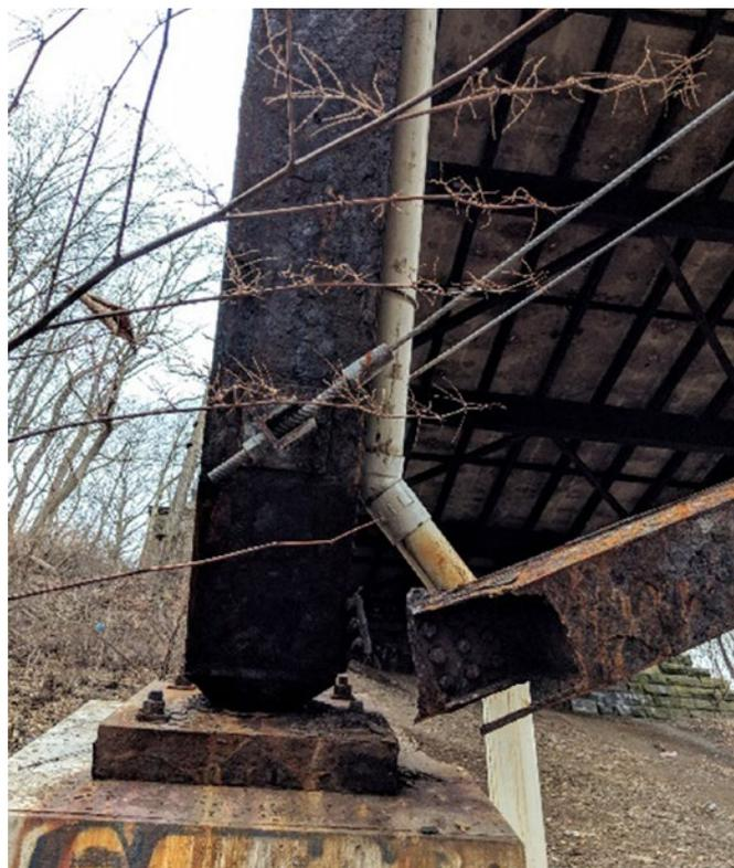
En conclusion, le NTSB recommande à l'usage des maîtres d'ouvrage de ponts en acier auto-patinable une maintenance active de leurs ouvrages, afin de permettre une évacuation normale des eaux de pluie et d'éviter l'accumulation de débris risquant de piéger de l'eau stagnante.
