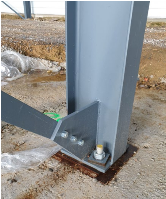
Figure 74: Exemple d'un platine de pied de poteau articulé reliée à une diagonale de contreventement
