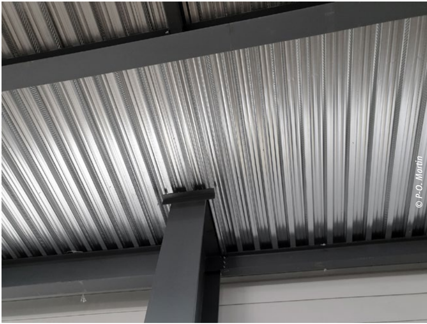
Figure 161 : Cornière pour le support local d'une nervure
