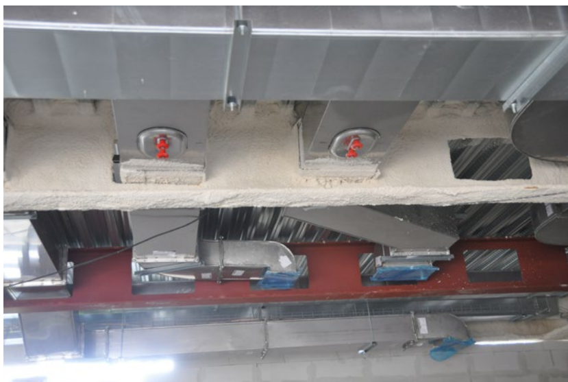
Figure 91: Exemple de passage de gaines à travers des ouvertures d'âme
