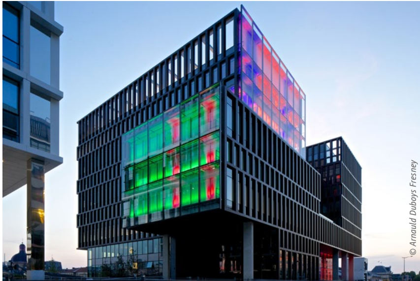
Figure 2 : Immeuble de bureaux quartier Austerlitz – Ateliers 2/3/4, arch. – Paris, 2017
