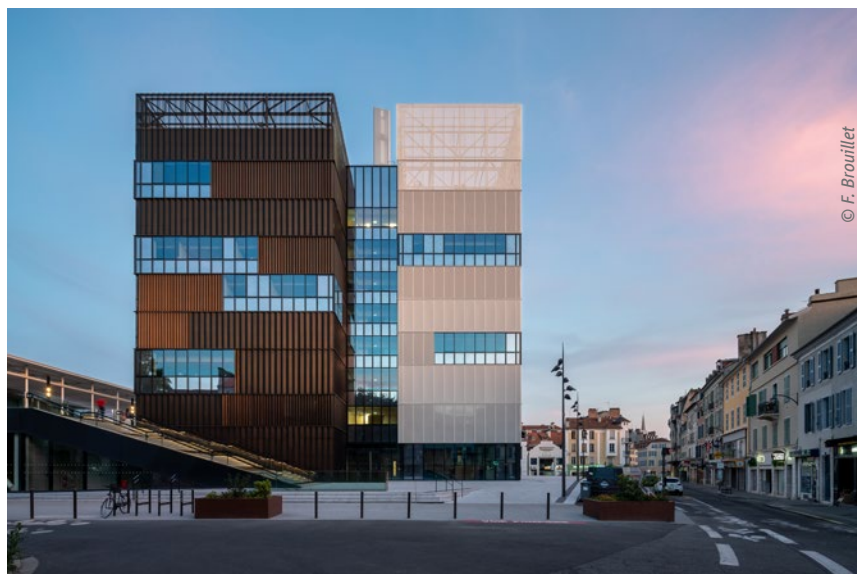
Figure 5: Bâtiment de bureaux – Halles de Pau - Ameller Dubois arch. - 2017
