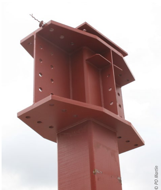
Figure 60: Exemple de poteau à section creuse carrée
