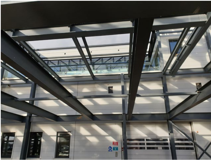
Figure 93: Solives au premier plan supportées par des poutres principales en arrière-plan
