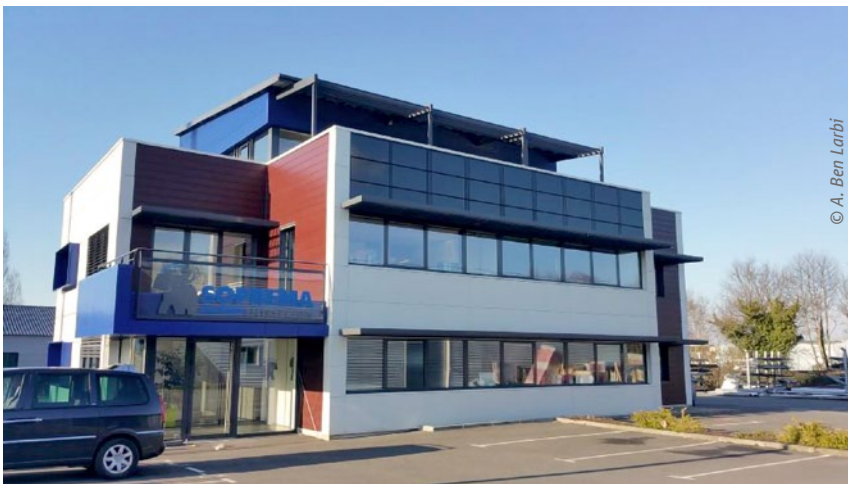
Figure 4 : Bâtiment de bureaux – SOPREMA Rennes
