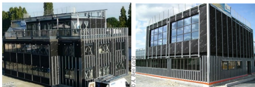
a) Bâtiment de bureaux R+2 à Rennes (2011) Perméabilité à l'air Q_{4Pa-surf} = 0,15 \text{ m}^3/\text{h.m}^2
