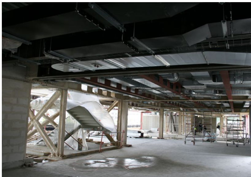
Figure 39: Exemple d'un plancher avec protection incendie partielle
