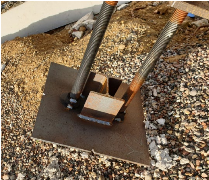
Figure 73: Exemple d'une platine avant pré-scellement dans le massif de fondation
