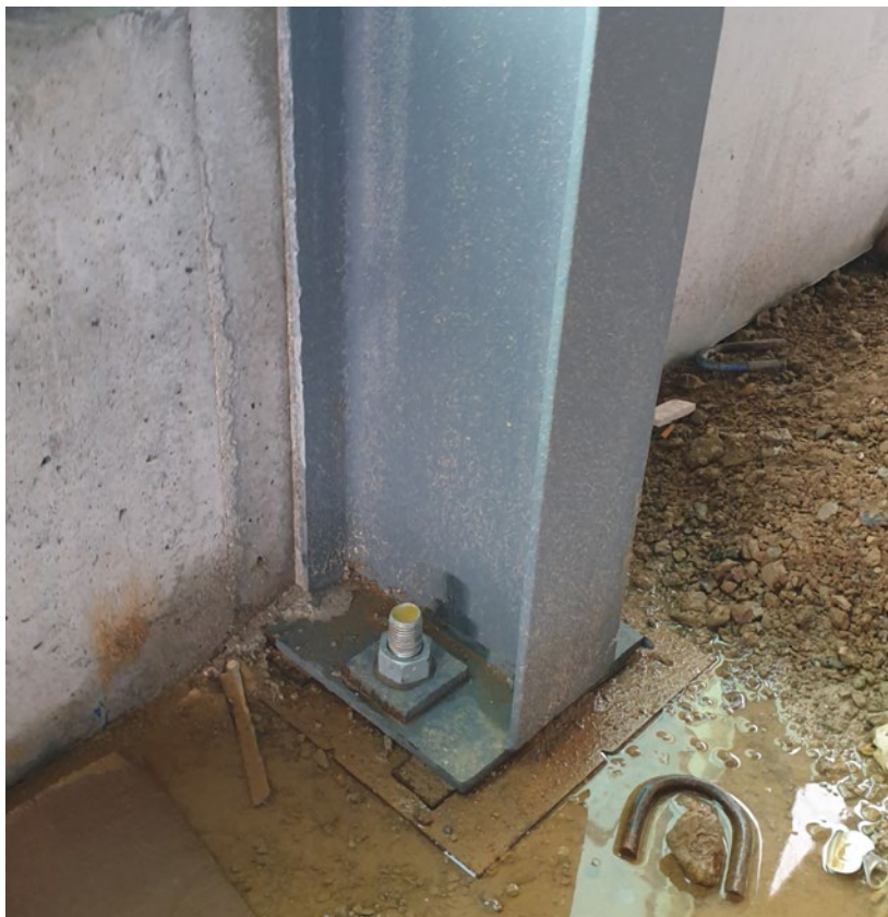
Figure 72: Exemple d'un pied de poteau articulé avec platine pré-scannée et contreplaqué
