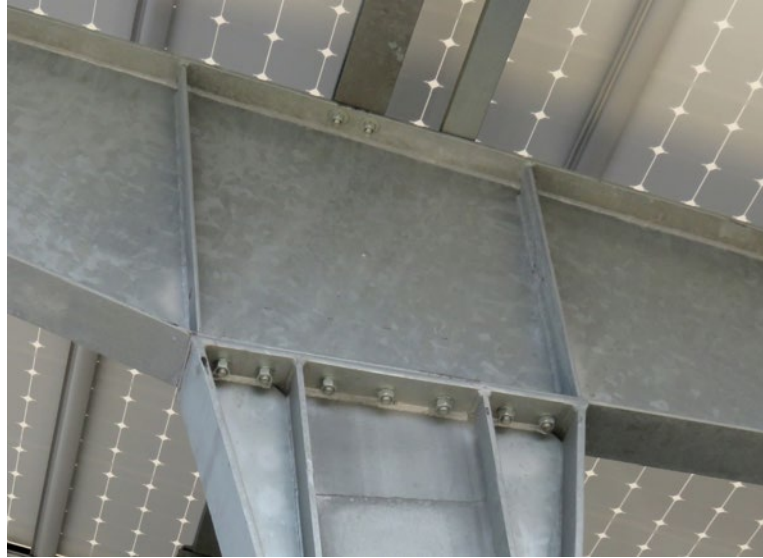
Figure 170: Assemblage de poutre posée sur poteau
