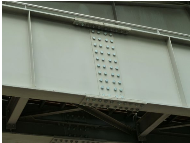
Figure 149: Couvre-joints de continuité
