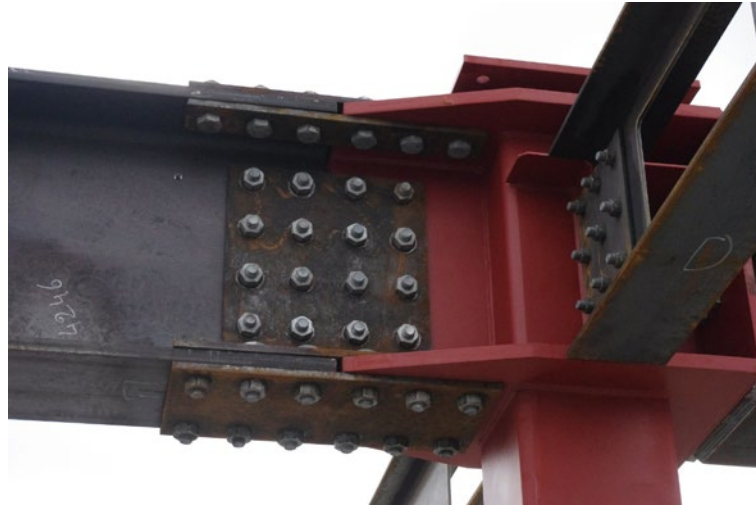
Figure 152: Eclissage d'une poutre sur un poteau
