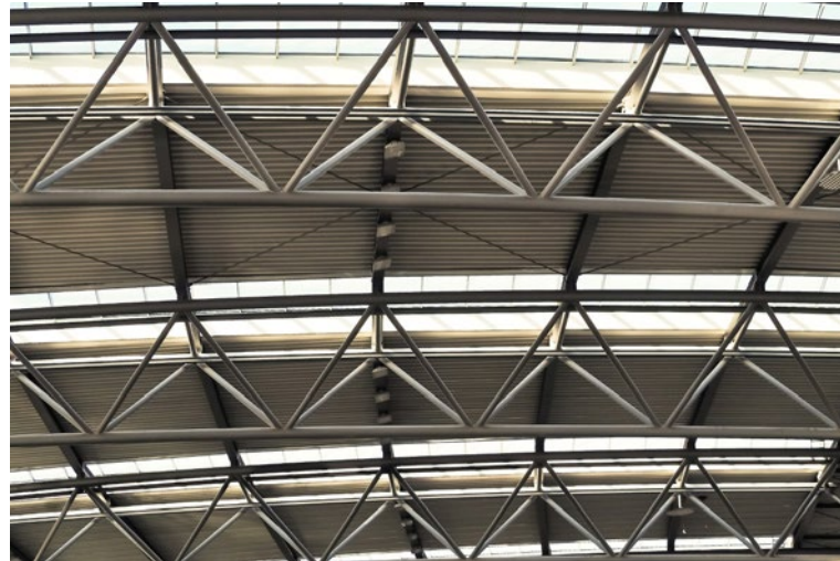
Figure 56 : Exemple de treillis spatial utilisant des profils creux circulaires (Aéroport de Düsseldorf)
