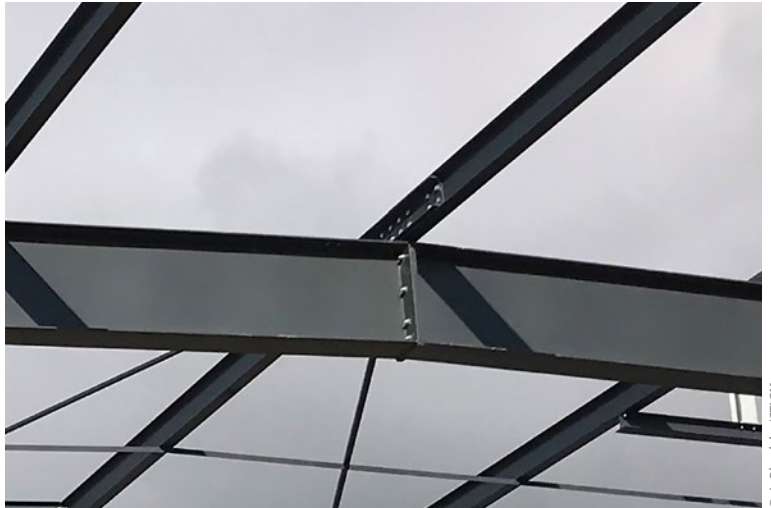
Figure 157: Exemple de continuité par platine d'about
