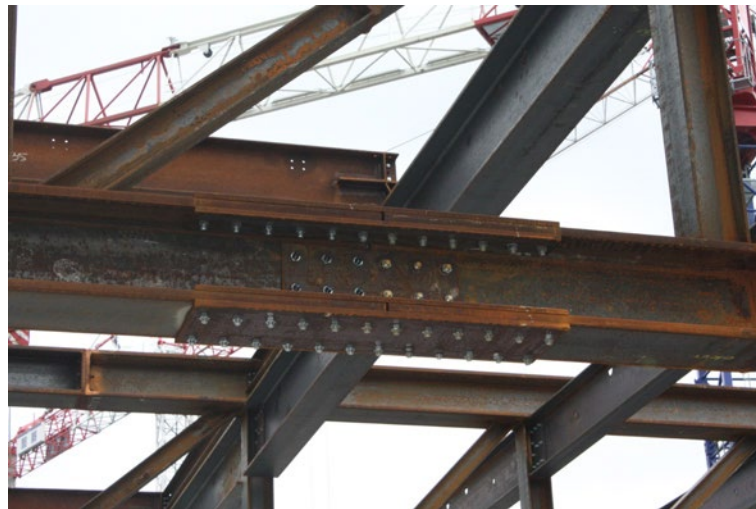
Figure 153: Exemple d'éclisse de continuité de membrure de poutre treillis
