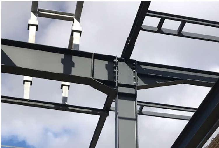
Figure 65: Assemblage poutre-poteau avec renfort de jarret
