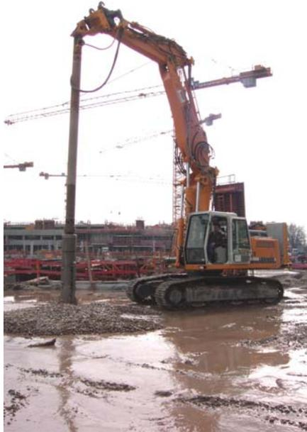
▲ Vibreur S 230 monté sur grue automotrice
