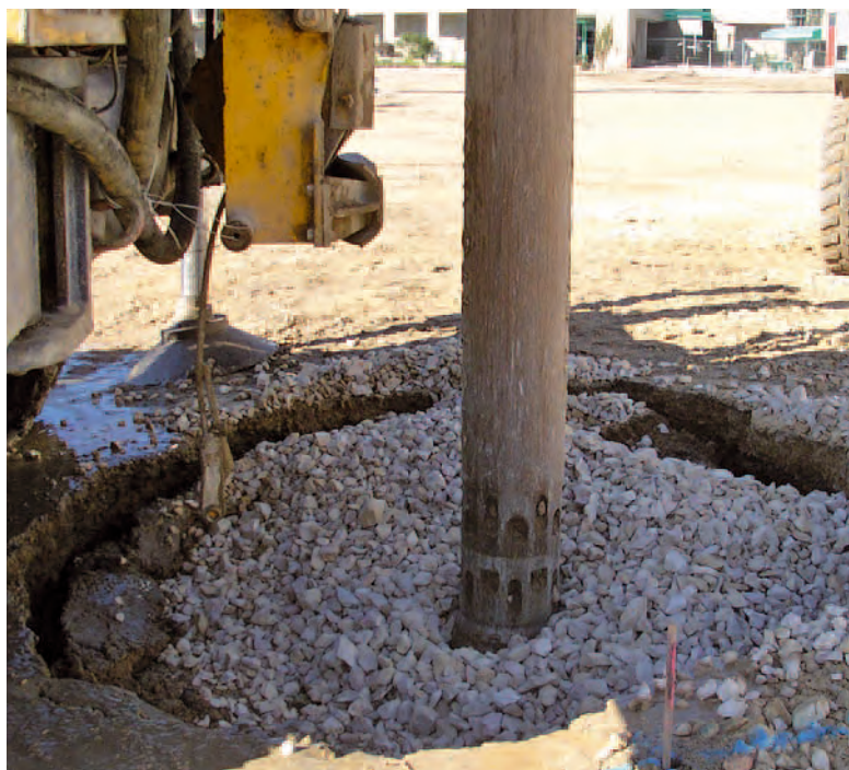
▲ Un cône d'affaissement apparaît autour du vibreur lors du compactage en profondeur
