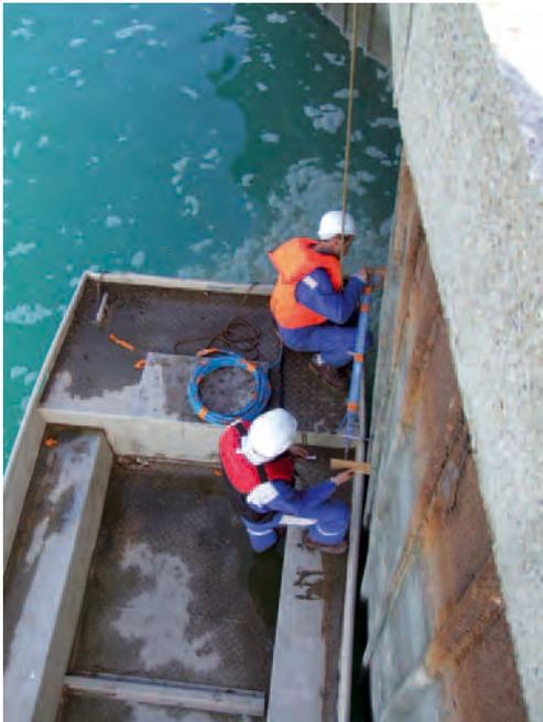
▲ Mise en place des capteurs de déplacement
