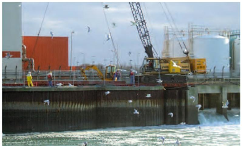
▲ Mise en station de la grue pour le vibrocompactage
