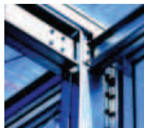
Structure en profils minces boulonnés. Viaduc espace info à Millau. M. Abergel et J. Carchon architectes.
