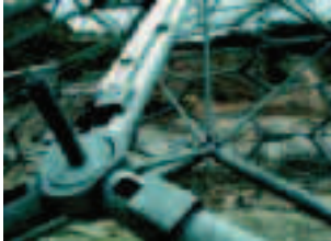
Nœud d'articulation en acier moulé. Structure de l'une des sphères d'Eden Project à Bodelva-Cornouailles en Angleterre. Nicholas Grimshaw and Partners architectes.
