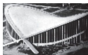
Exemple de structure à double courbure, paraboloid hyperbolique. Arène de Raleigh Livestock réalisée en 1953 par Matthew Nowici avec l'ingénieur Fred N. Severud.
