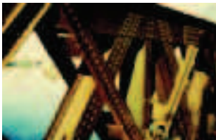
Pont en fer riveté à Bayonne, 1860.
