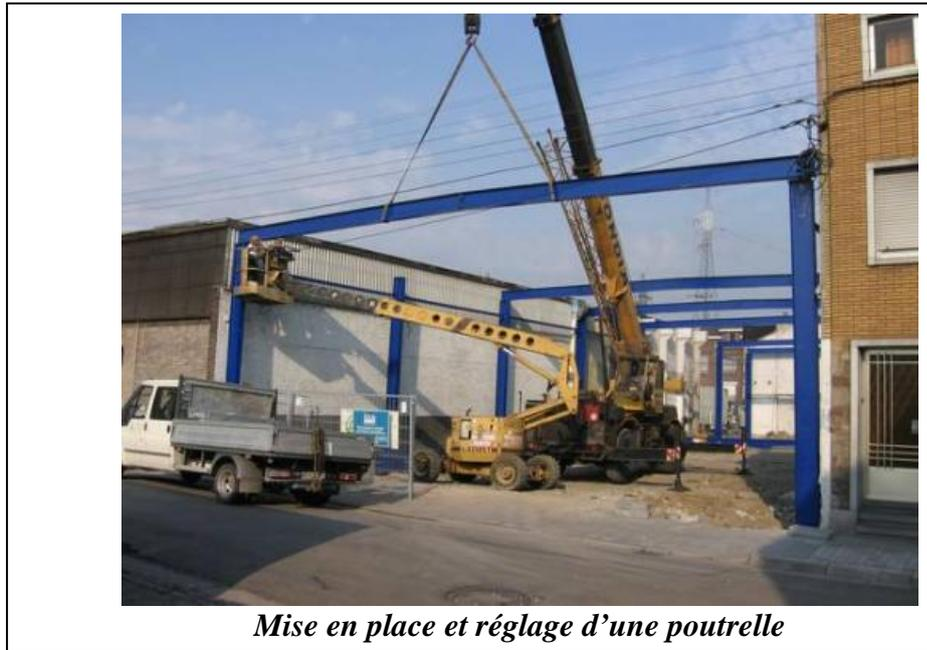
Les assemblages provisoires permettent la vérification de l'alignement, du nivellement et de l'aplomb. Une fois corrigés, on procède à l'assemblage définitif en serrant tous les écrous et en ajoutant les boulons qui n'ont pas été posés initialement.
