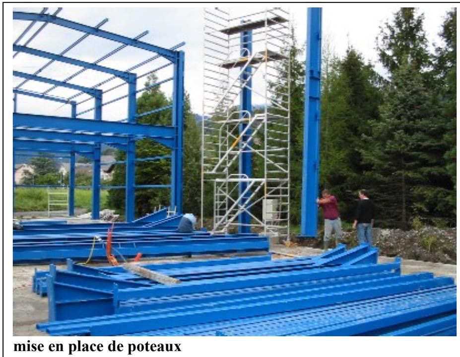
La priorité est donnée aux ouvrages « stabilisateurs » tels que les ensembles contreventés qui sont assemblés au sol. Les autres ouvrages (poutres, albâtriers,...) sont assemblés par la suite à ces éléments stabilisés.
