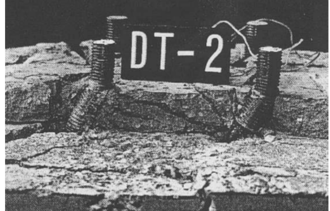
FIGURE 7.24 – Ruine de tiges d'ancrage due au cisaillement
