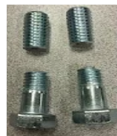
FIGURE 6.16 – Rupture de boulons par cisaillement
