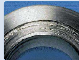
8.1-3 Le serrage au couple entraîne une détérioration des surfaces des éléments de l'assemblage. Les montages et démontages successifs accentuent ce phénomène
