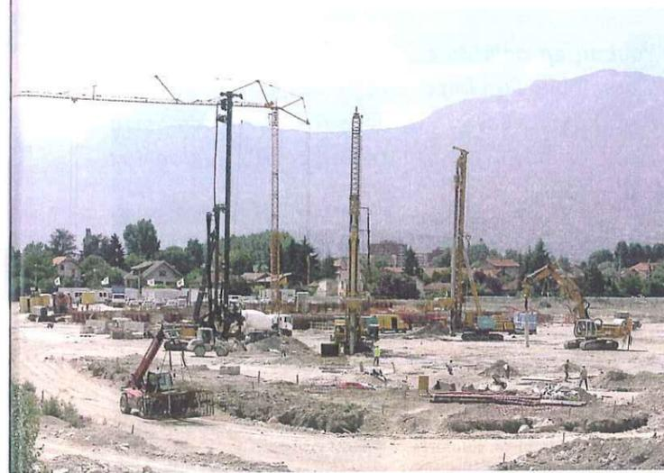
Réalisation des Colonnes à Module Mixte CMM®.
