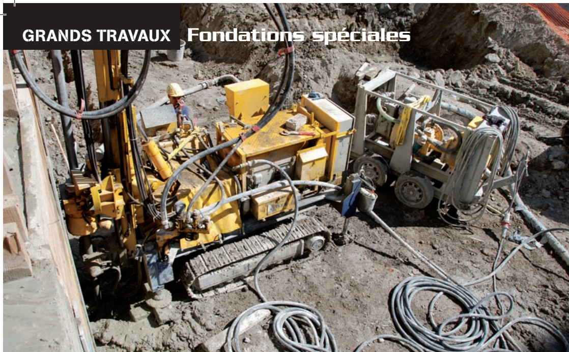
La foreuse Keller KB 1 pendant le forage des demi-colonnes de jet grouting de 6 m de hauteur.
