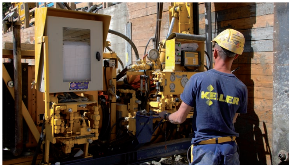
Tous les paramètres de forage sont contrôlés et enregistrés en permanence
