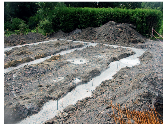
Les semelles filantes en béton armé sont coulées classiquement en pleine fouille, coiffant directement les colonnes ballastées qui renforcent le sol en profondeur sur la hauteur des terrains compressibles.
