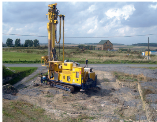
Vue d'un atelier en service pour un chantier de maison individuelle
