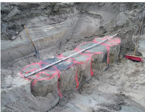
Colonnes de renforcement sous une pile de pont
