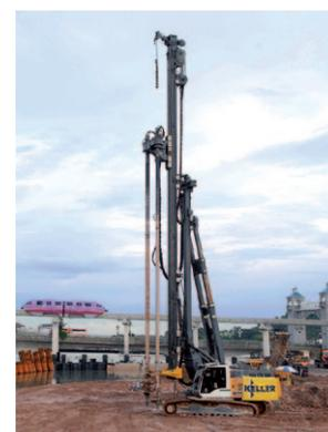
DSM dans un remblai hydraulique à Singapour
