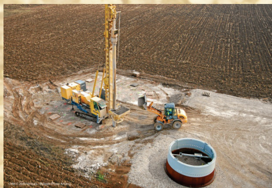
▲ Réalisation de colonnes ballastées depuis le TN
