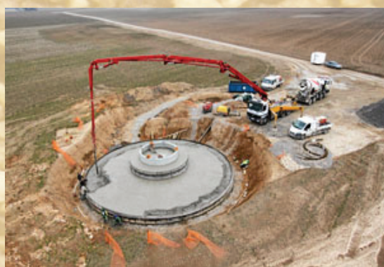
▲ Coulage de la semelle de l'éolienne
