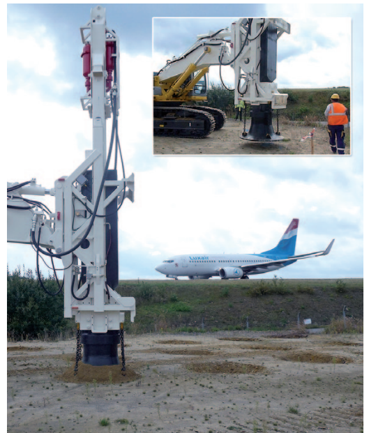
Extension de la plateforme Höhenhof de l'aéroport du Findel (Luxembourg) en 2009 · Surface traitée : 6.635 m 2
