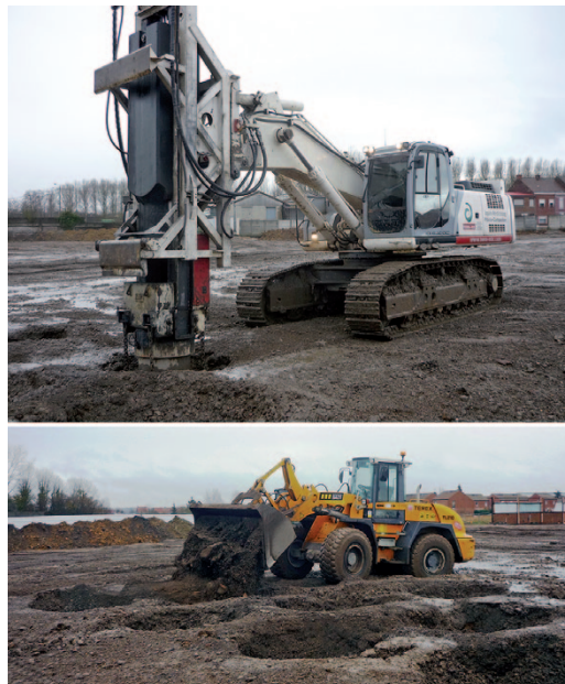
Construction d'un supermarché Match à Quiévrechain (59) en 2012 · Surface traitée : 13.000 m 2
