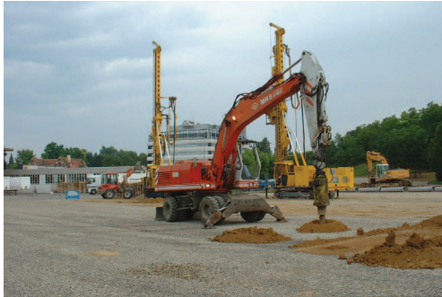
▲ Préforage de la plate-forme traitée
