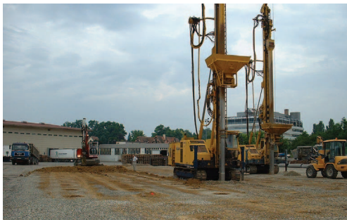
▲ Réalisation des colonnes ballastées sous dallage
