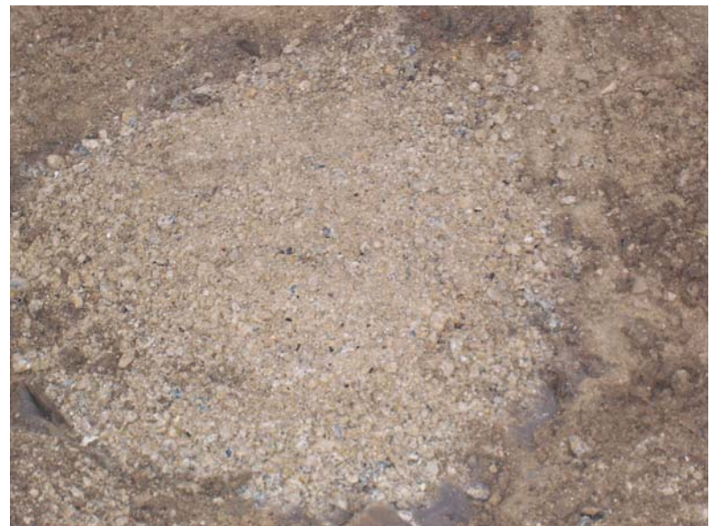
▲ Dégarnissage d'une colonne ballastée (dim. 85 x 100 cm)
