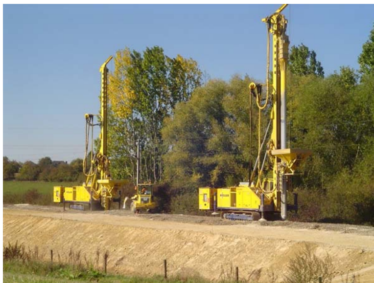
▲ Foreuses en action sur la voie de chemin de fer
