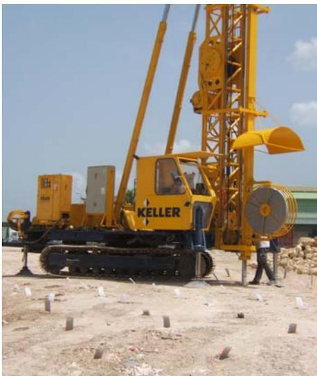
▲ Réalisation des drains verticaux ▼
