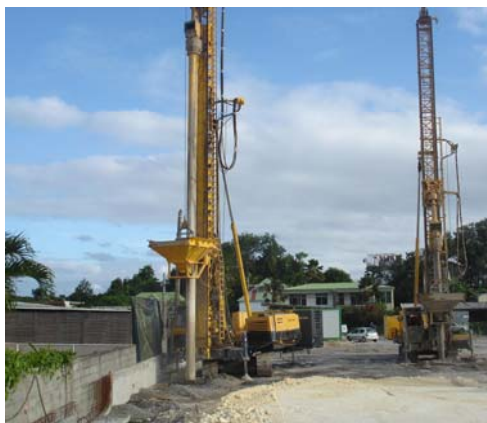
▲ Réalisation de colonnes ballastées à proximité des murs avoisinants
