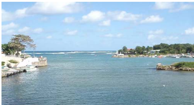
▲ Photo : avant travaux
