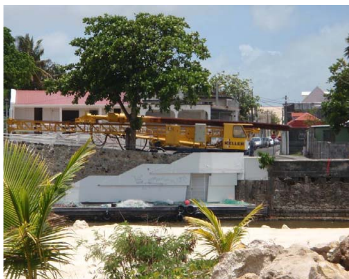
▲ Arrivée de l'atelier sur le site de la culée C1
