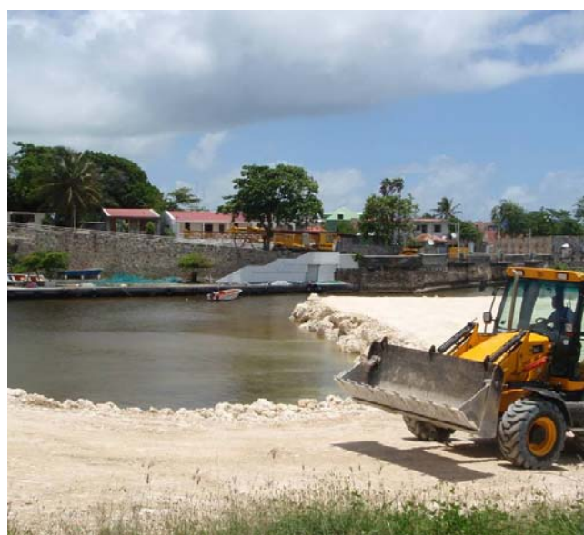
▲ Au niveau de la culée C2, une rampe d'accès en tuf a été construite afin de permettre la réalisation des travaux
