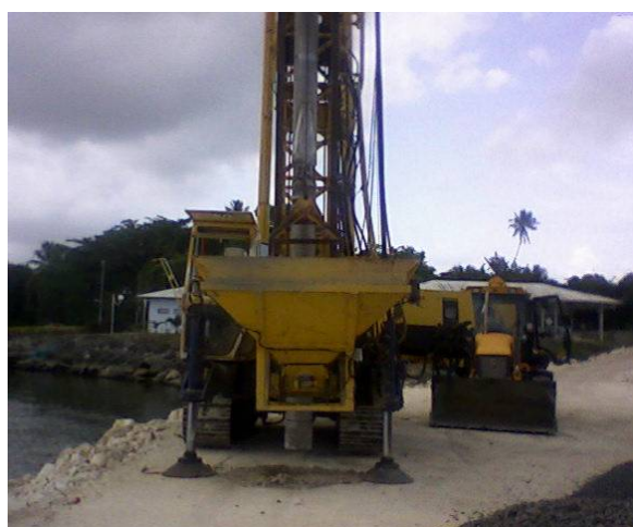
▲ Au niveau de la culée C2, une rampe d'accès en tuf a été construite afin de permettre la réalisation des travaux
