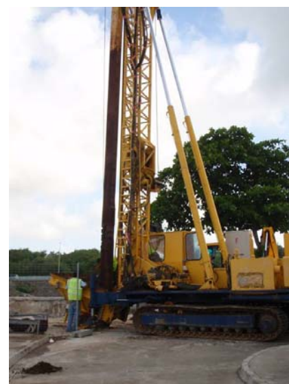
▲ Montage de l'atelier
