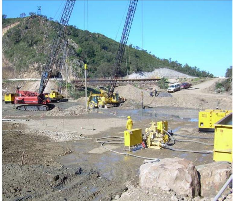
▲ Réalisation de colonnes ballastées en voie humide
