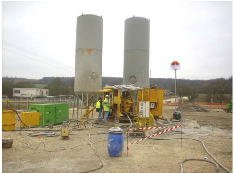
▲ Installation de la centrale à coulis
