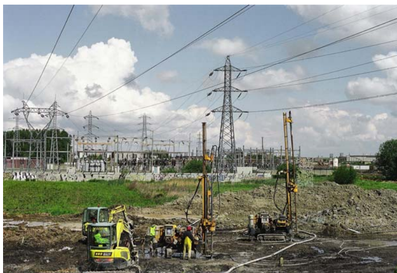
▲ Réalisation des colonnes sous la ligne RTE
