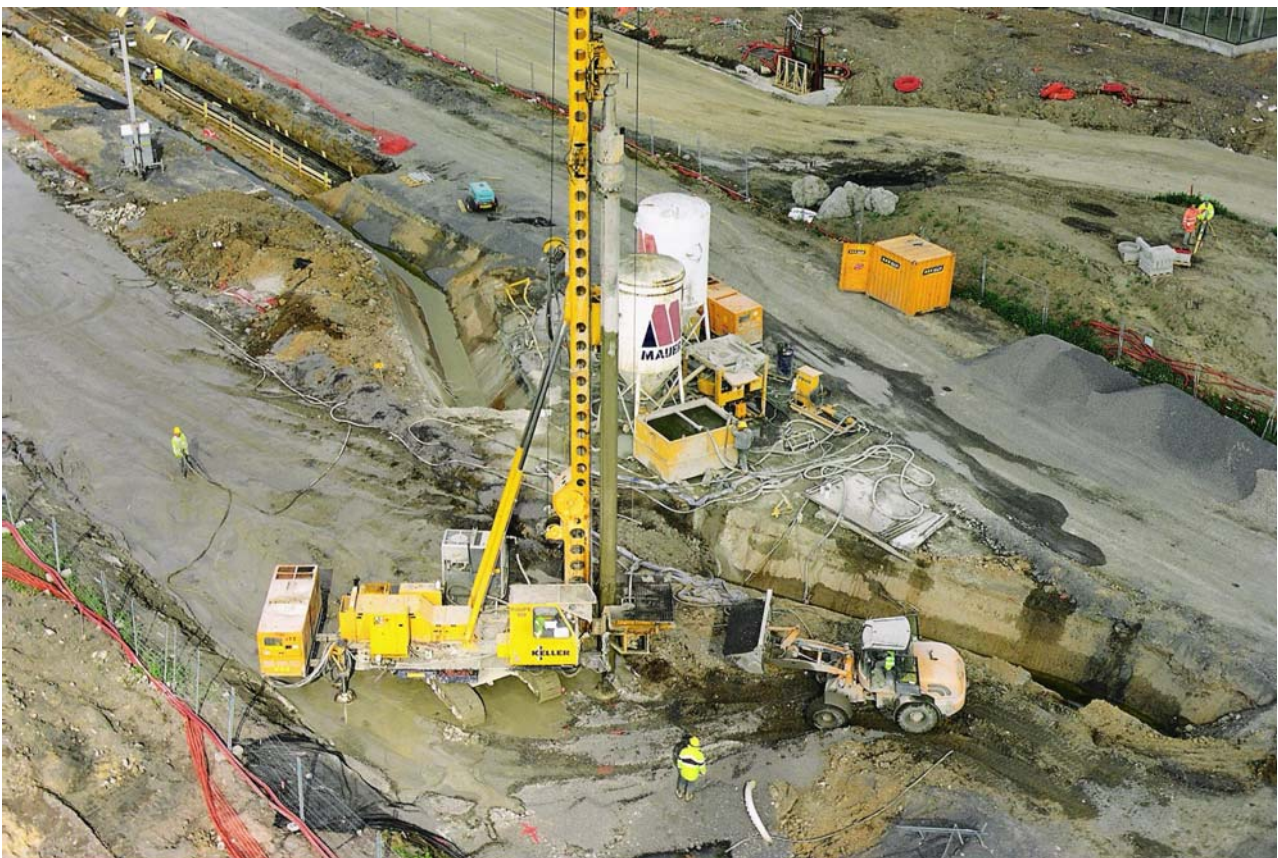
▲ Vue aérienne d'une installation complète pour le renforcement de sol
