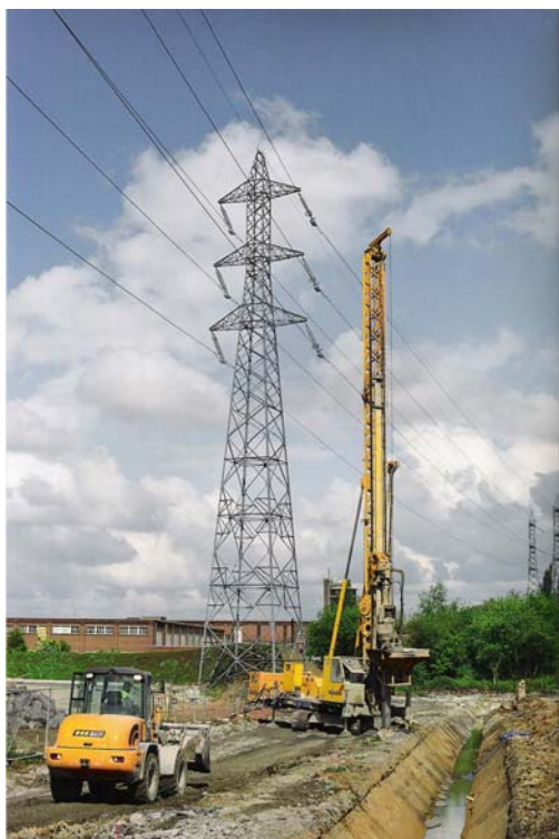
▲ Réalisation des colonnes au droit de la future voirie
