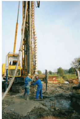
▲ Mise en place de la cage d'armature
