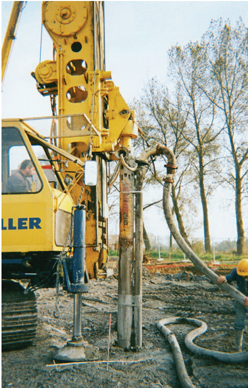
▲ Réalisation du pieu
