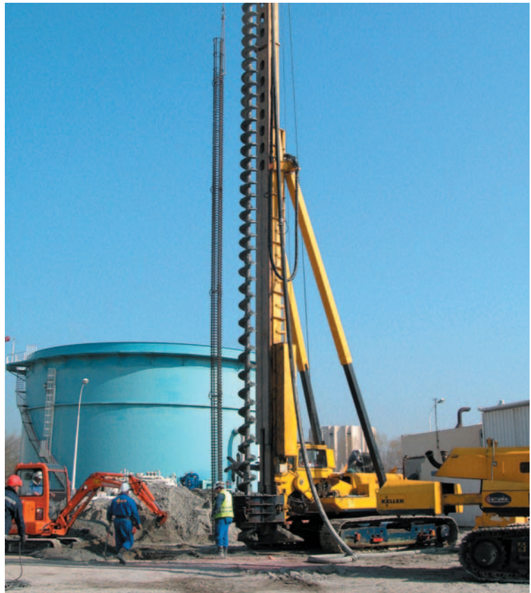
▲ Mise en place de la cage d'armature
