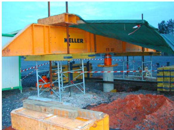
▲ Essai de chargement statique vertical
