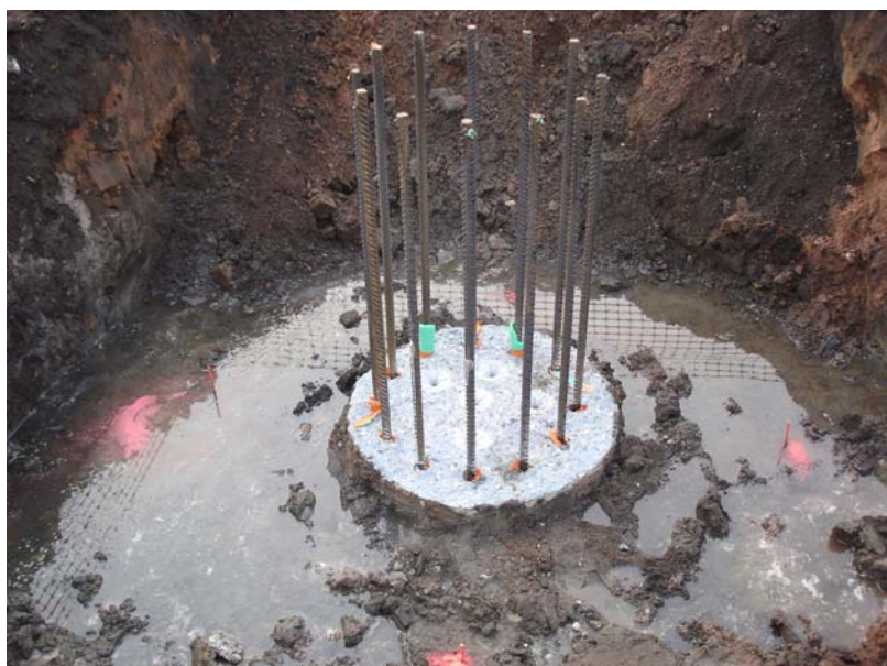
▲ Tête de pieu après recépage
