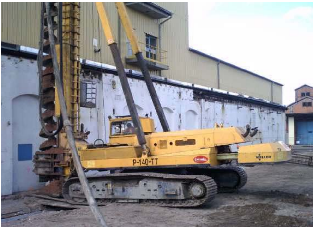
▲ Réalisation d'un pieu à proximité d'un ouvrage existant
