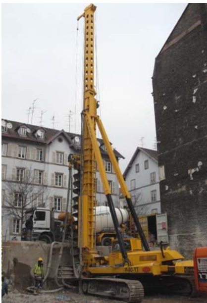
▲ Réalisation d'un pieu de structure côté rue
