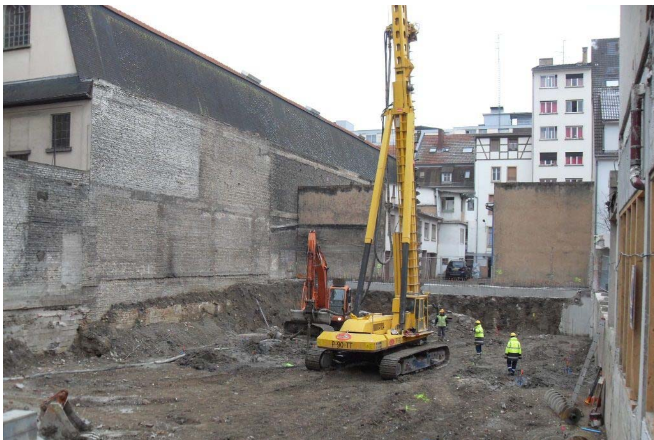
▲ Vue d'ensemble du chantier
