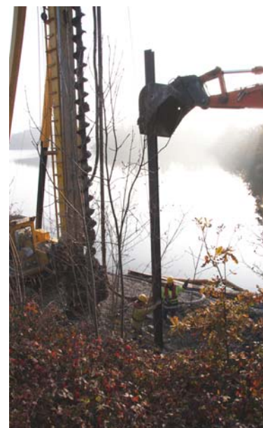
▲ Mise en œuvre du profilé métallique
