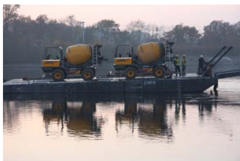
▲ Transport du béton sur ponton
