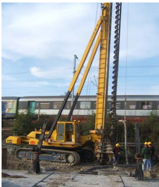
▲ Mise en station pour forage
