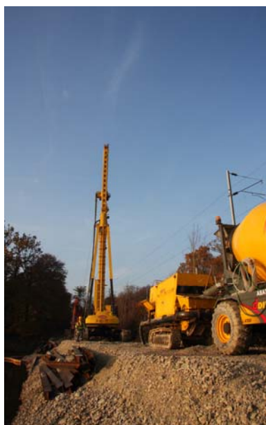
▲ Bétonnage d'un pieu
