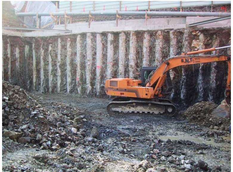
▲ Excavation de la fouille
