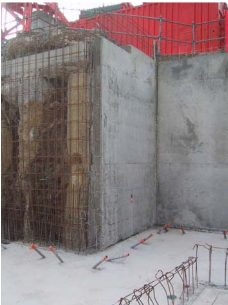
▲ Voile contre pieux
