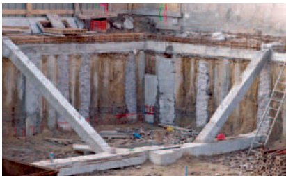
▲ Paroi après butonnage et pose des longrines
