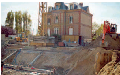
▲ Paroi en cours de butonnage
