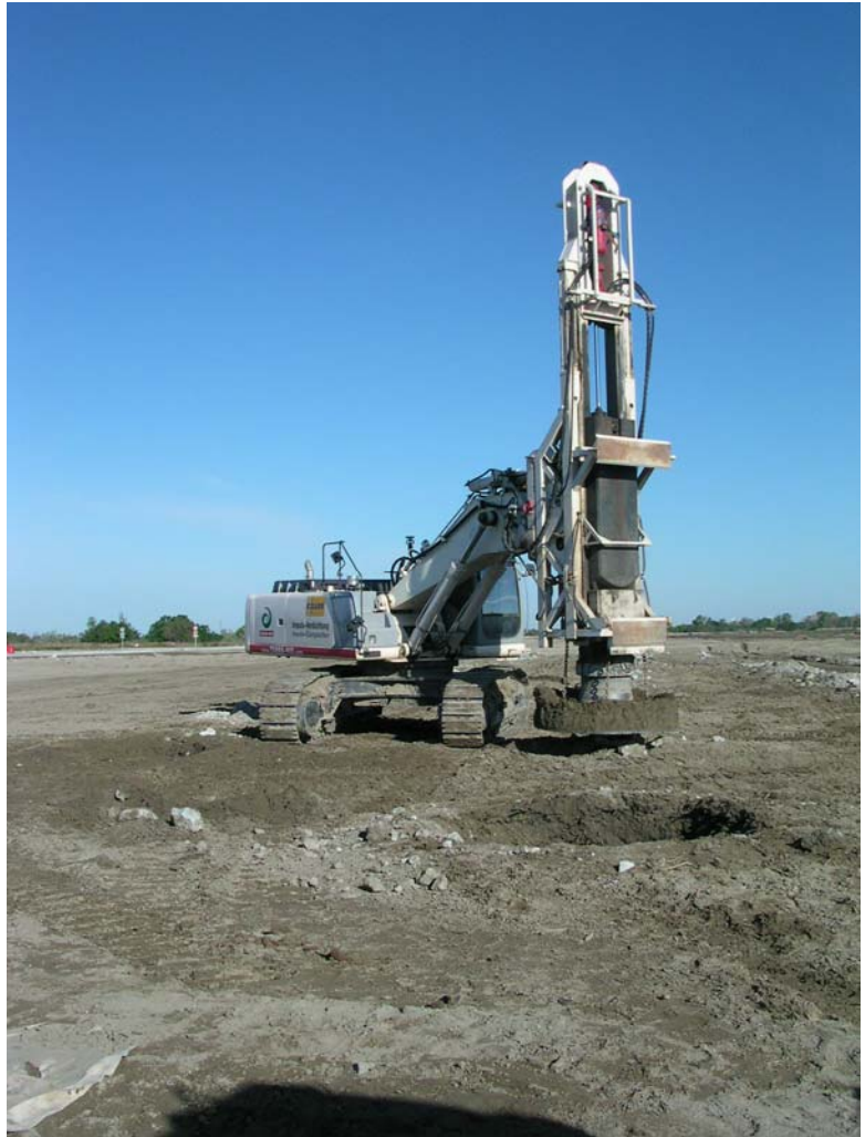
▲ Travaux de compactage par le procédé "Rapid Impact Compaction"
