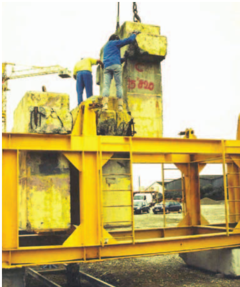
Essai de chargement statique
