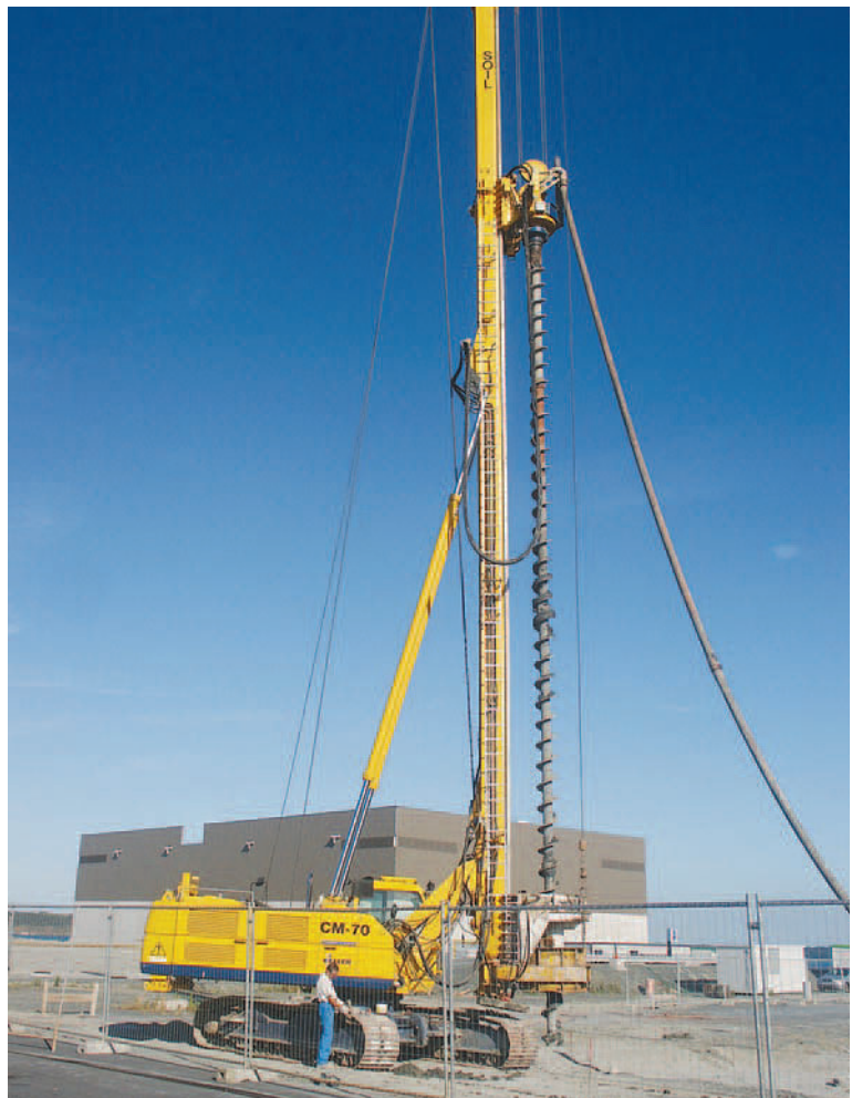
▲ Foreuse CM 70 en cours de réalisation des pieux supports de charpente métallique
