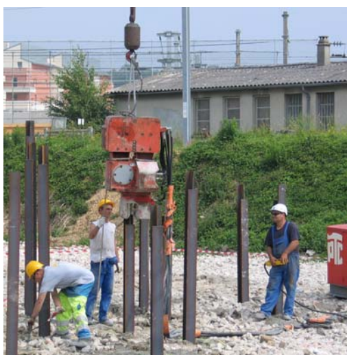
▲ Mise en place des profilés métalliques dans les inclusions fraîches
