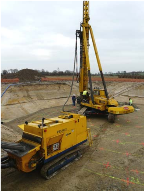
▲ Réalisation de la partie rigide des CMM®
