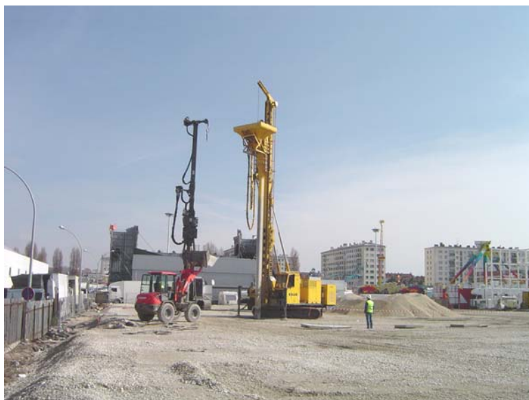
▲ Réalisation des Colonnes à Module Mixte CMM®
