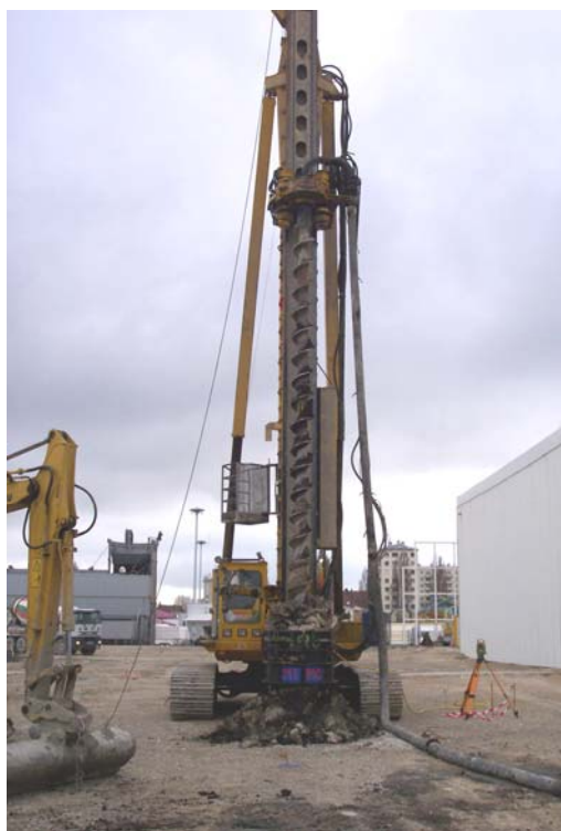
▲ Réalisation des pieux
