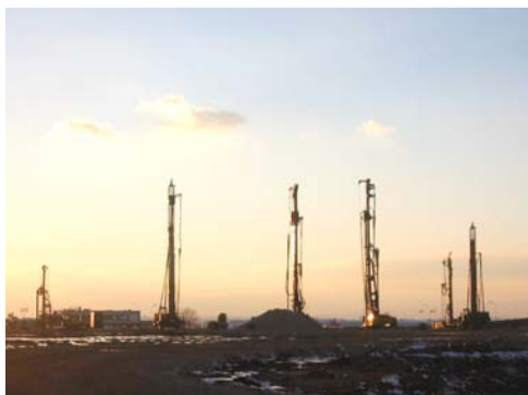
▲ Chantier en cours d'exécution avec les 6 ateliers
