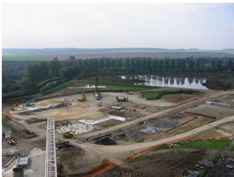
▲ Vue du site pendant les travaux (on distingue les empreintes des futurs ouvrages)
