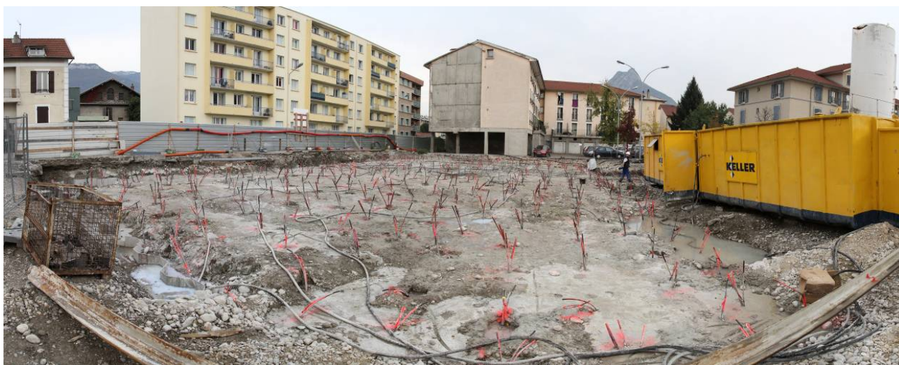
▲ Site après réalisation du bouchon injecté
