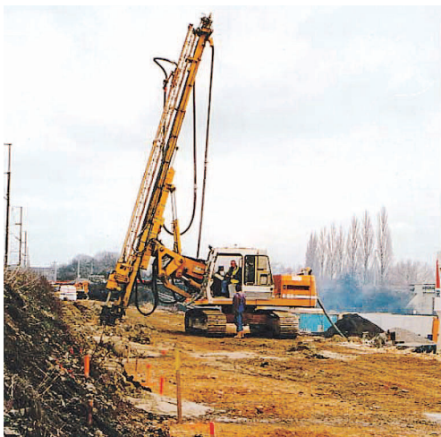
▲ Réalisation d'une colonne de Compaction Grouting
