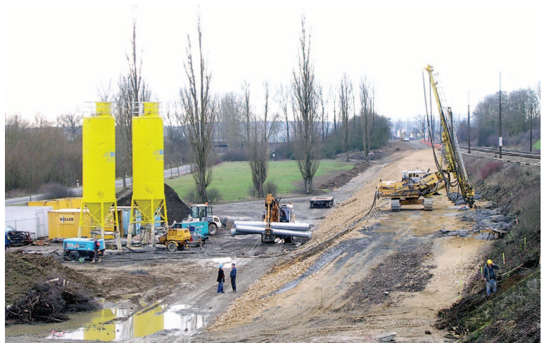
▲ Vue d'ensemble du chantier
