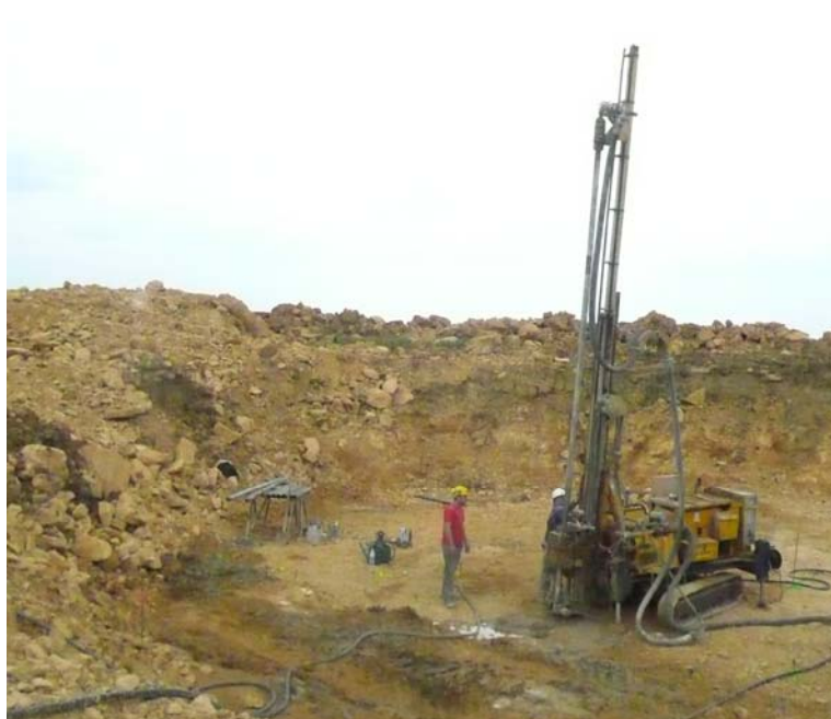
▲ Vue générale de la foreuse lors des travaux
