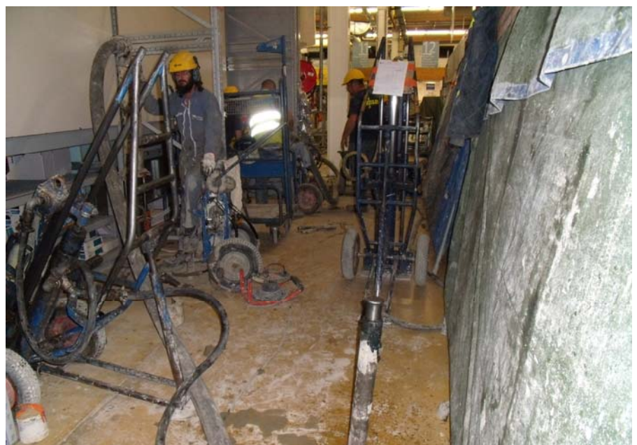
▲ Zone de forage et protection provisoire durant les travaux de nuit (magasin en activité le jour)
