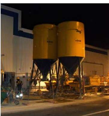
▲ Installation travaux de nuit
