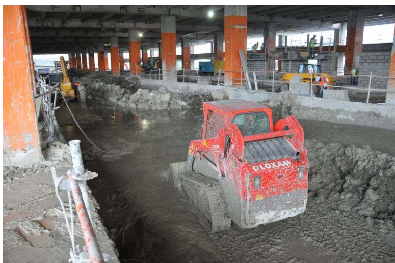
▲ Ensemble du chantier sous existant : stockage des spoils
