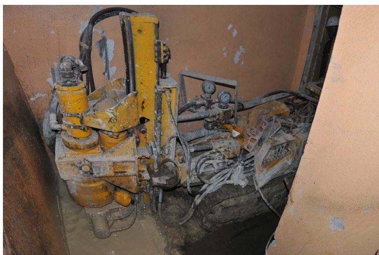
▲ Foreuse KB dans la cage d'escalier
