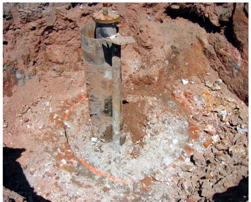
▲ Dégarnissage puits 1
