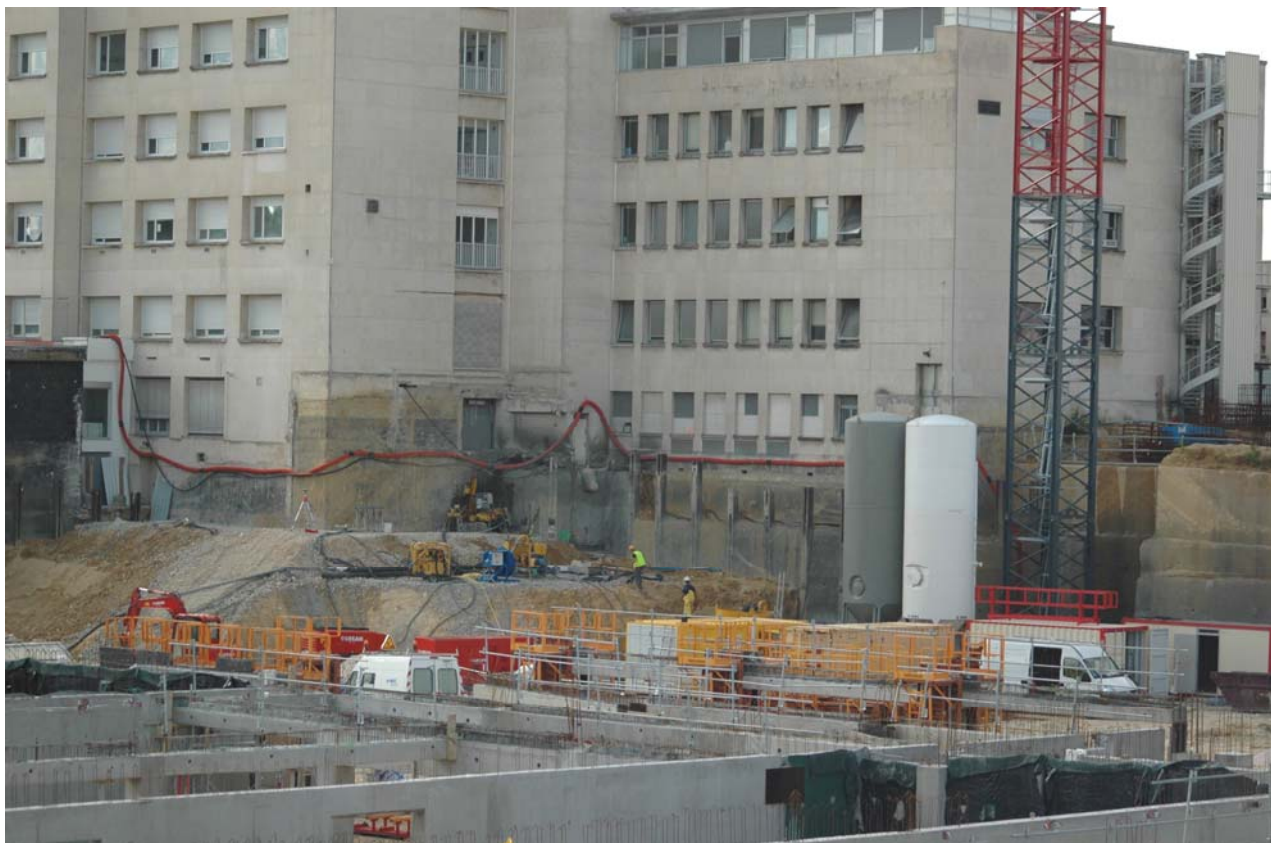
▲ Réalisation des travaux de jet grouting sous la semelle, avant terrassement
