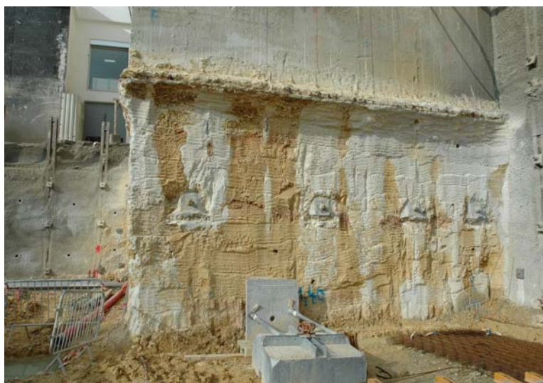
▲ Paroi en jet grouting rabotée, située sous la semelle du bâtiment existant
